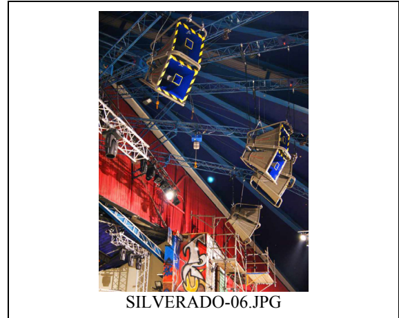
Foto 4: Vier 2er-Cluster unter der Decke des Theaters an der Traversen Spinne
