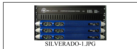
Foto 3: Powersoft M-Serie Endstufen und HD2 Controller unter der Bühne des Theaters
